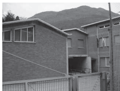
La scuola media di Vezzano
