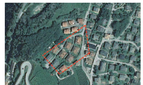
(Vista aerea zona interessata dai lavori dell'Intervento "B")
