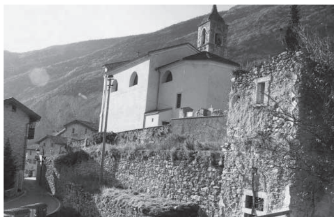
Vista da Nord – Est - PRIMA
