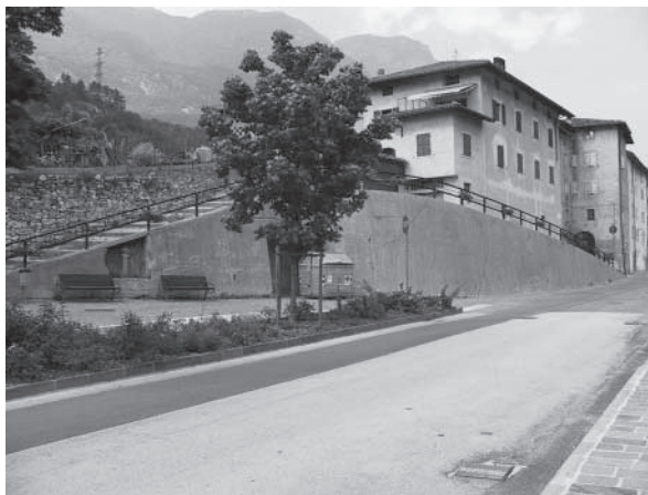
Muro da ristrutturare
