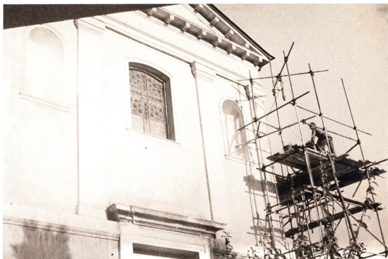
Perforazione del muro di facciata: si esce nella nicchia di sinistra.
