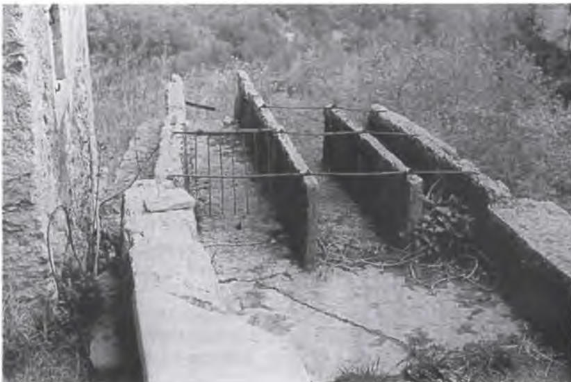
La ripartizione dell'acqua attraverso i 3 canali, che servivano per azionare altrettante "macchine" (molino, maglio, ...).
