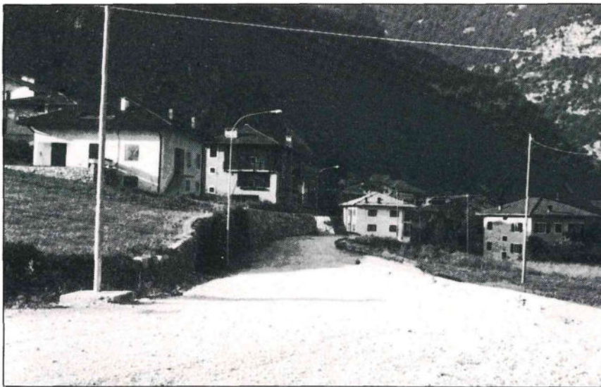
Un tratto della variante di Ranzo che collega la parte bassa del Paese alla strada di accesso alla frazione è uno dei lavori realizzati recentemente.
