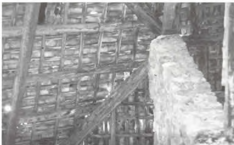
Foto 5: "coèrt en cópi" visto da sotto
