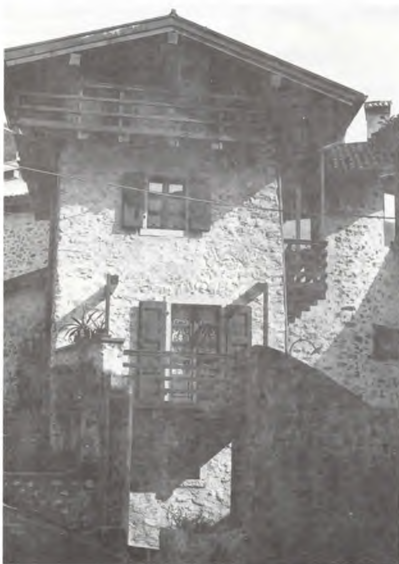
Foto 1: Casa Pederzolli a Stravino
