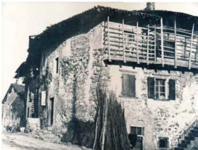
Terlago - Via Negriolli: le nostre case rurali erano caratterizzate dalla frequente presenza di ballatoi e graticci che servivano a far essiccare le pannocchie ma anche le barbabietole.
