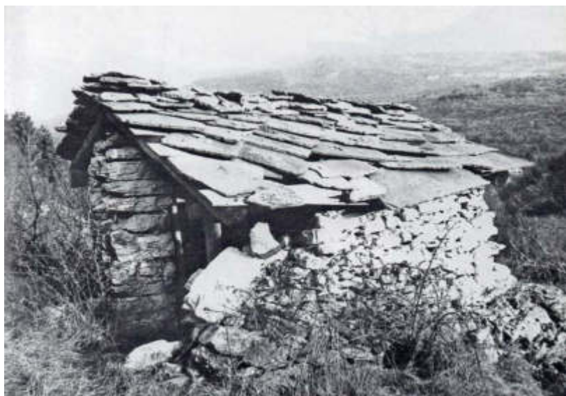
Terlago - Doss Castion: casolare di campagna costruito in pietre di scaglia grigia, a secco, tipica costruzione accessoria alle case contadine chiamata "bait".
