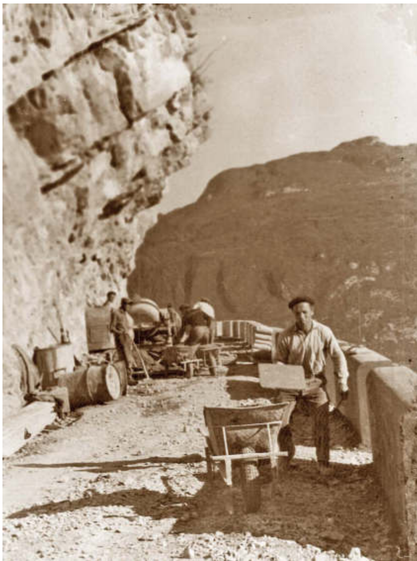
Ranzo 1950: lavori in località Rocion per la costruzione della strada di collegamento a Vezzano.
