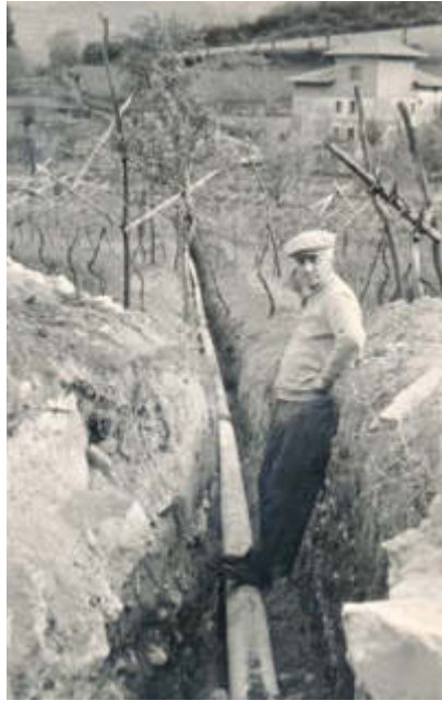
Terlago 1954: posa dell'impianto irriguo. Sullo sfondo il mulino Defant.
