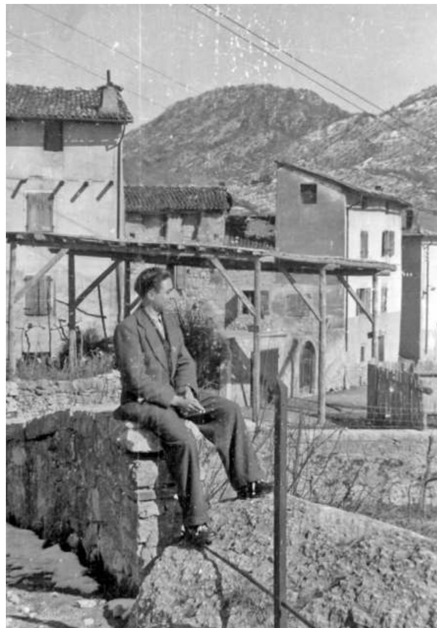
Vezzano - Via Dante 1915/18: una tettoia sopra la strada proteggeva i passanti da eventuali perdite di carico dalla teleferica.
