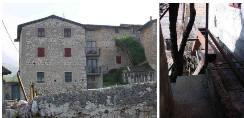
Nel 2007 all'esterno del mulino Garbari c'erano ancora le condotte che un tempo alimentavano le ruote idrauliche.
