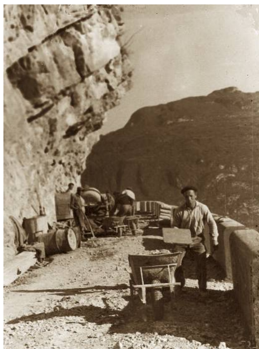
Ranzó 1950 - Lavori stradali al "Roción"
