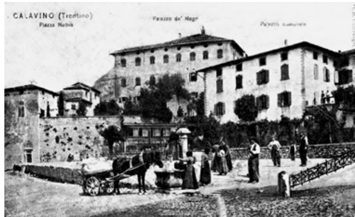
La piazza nel 1908 a fine lavori
