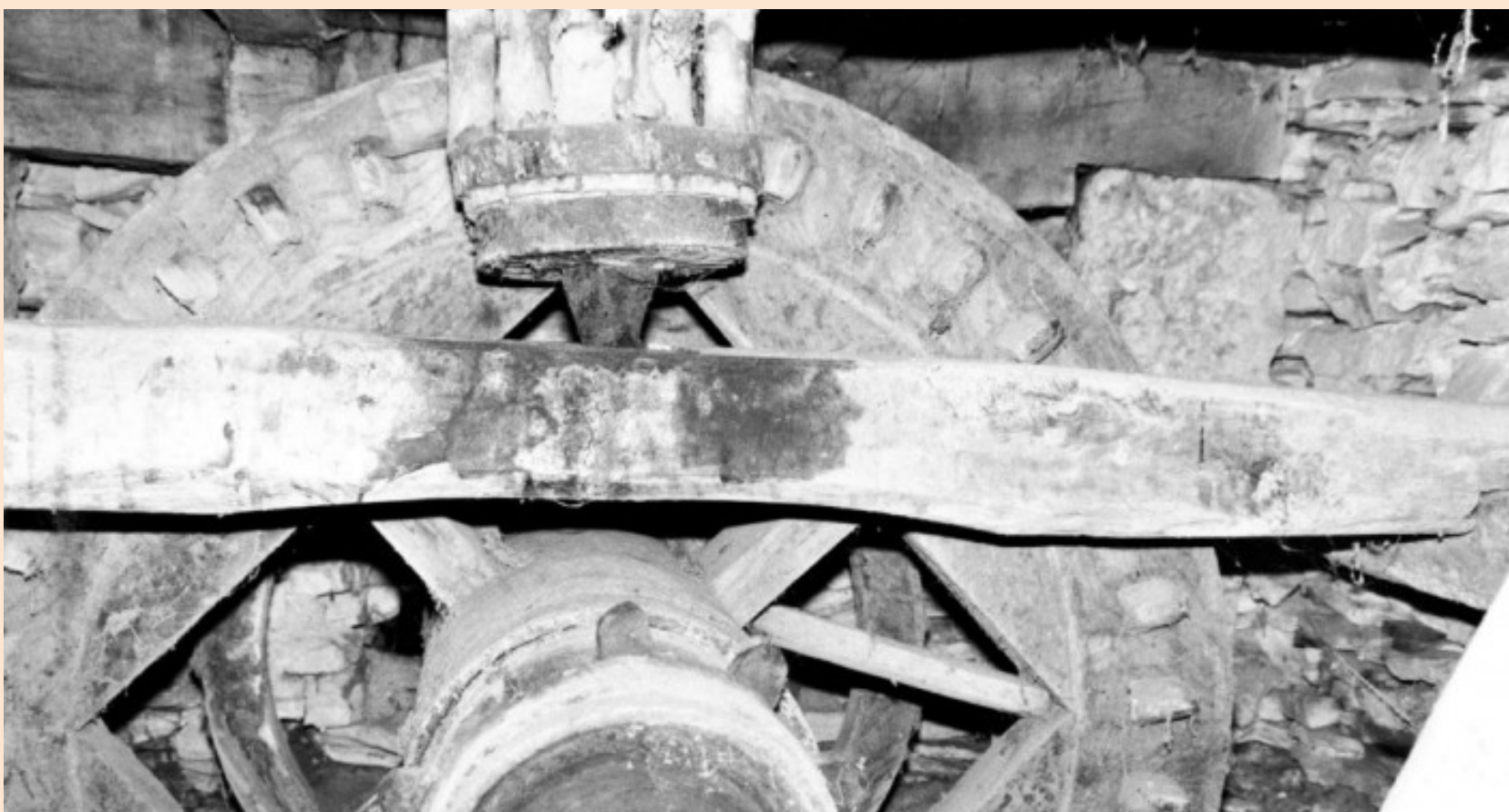
Ingranaggi del mulino Cattoni Gears from Cattoni mill
