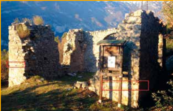
Fig. 11. Chiesa di San Martino di Pramerlo. Evidenziate in rosso le lastre reimpiegate nei perimetrali.
