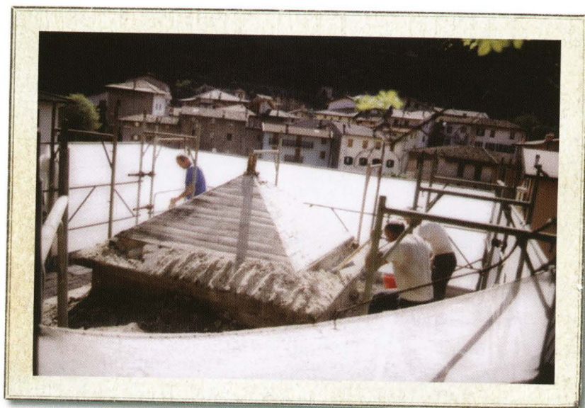
LAVORI DI RESTAURO SUL TETTO DELLA CAPPELLA (2004)
