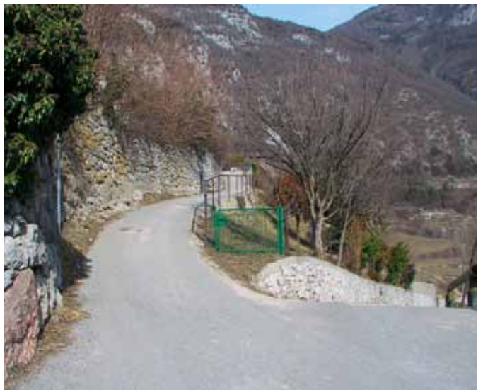
Panoramica di Via al Somados dove è previsto l'allargamento.
