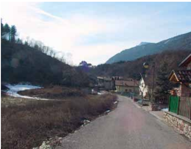
Panoramica di Via al Monte Gazza a Lon dove è previsto l'intervento.
