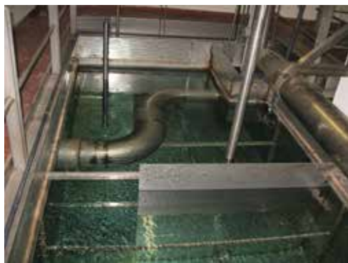
Una panoramica della vasca di calma dove viene potabilizzata l'acqua.
