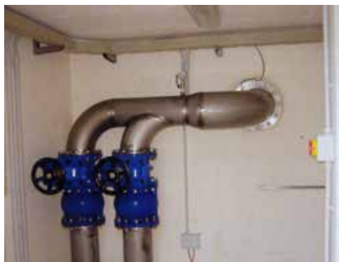
L'interno della stazione di sollevamento con il collettore di mandata.
