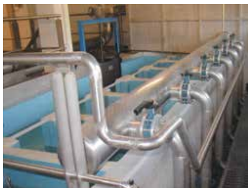
Le vaschette di riparto dei diversi acquedotti e il collettore by-pass.
