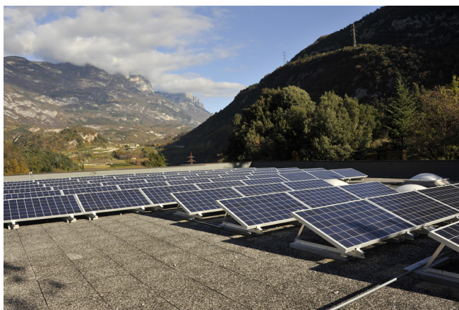
Installazione pannelli fotovoltaici - scuola materna
