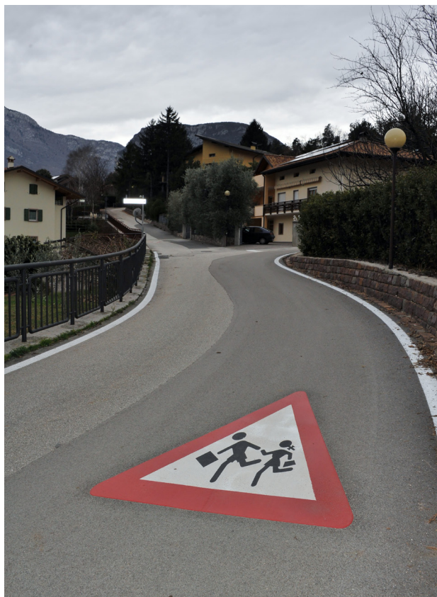
Realizzazione segnaletica stradale
