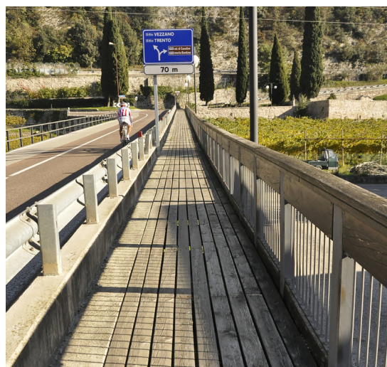
Manutenzione passerella che collega il paese con il cimitero
