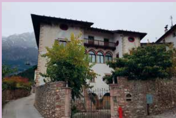
Facciata ad est che evidenzia il tipico loggiato.
