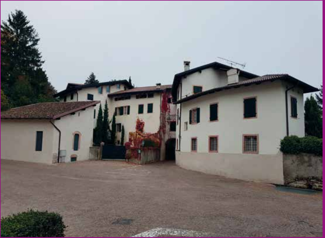
Prospetto ovest nel quale si sono evidenti le costruzioni da cui è composta.
