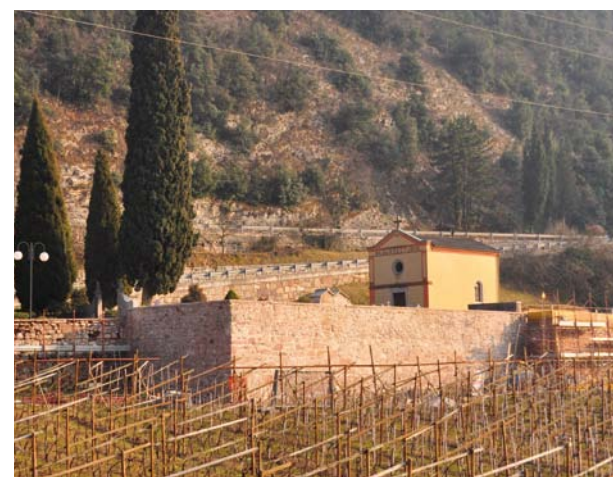
Rifacimento Muri perimetrali del Cimitero Comunale. Impresa D.Z. Servizi & C. s.n.c. Progettista : studio associato arch. Faes & Patton Importo lavori 199.986,00 euro
