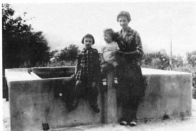
Lavatoio in cemento - n. 5
