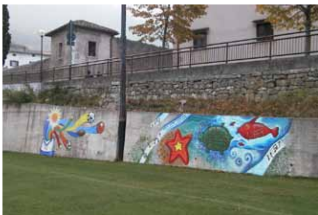
La realizzazione del muro sul lato Sud per l'allargamento del campo sportivo (luglio 2000)
