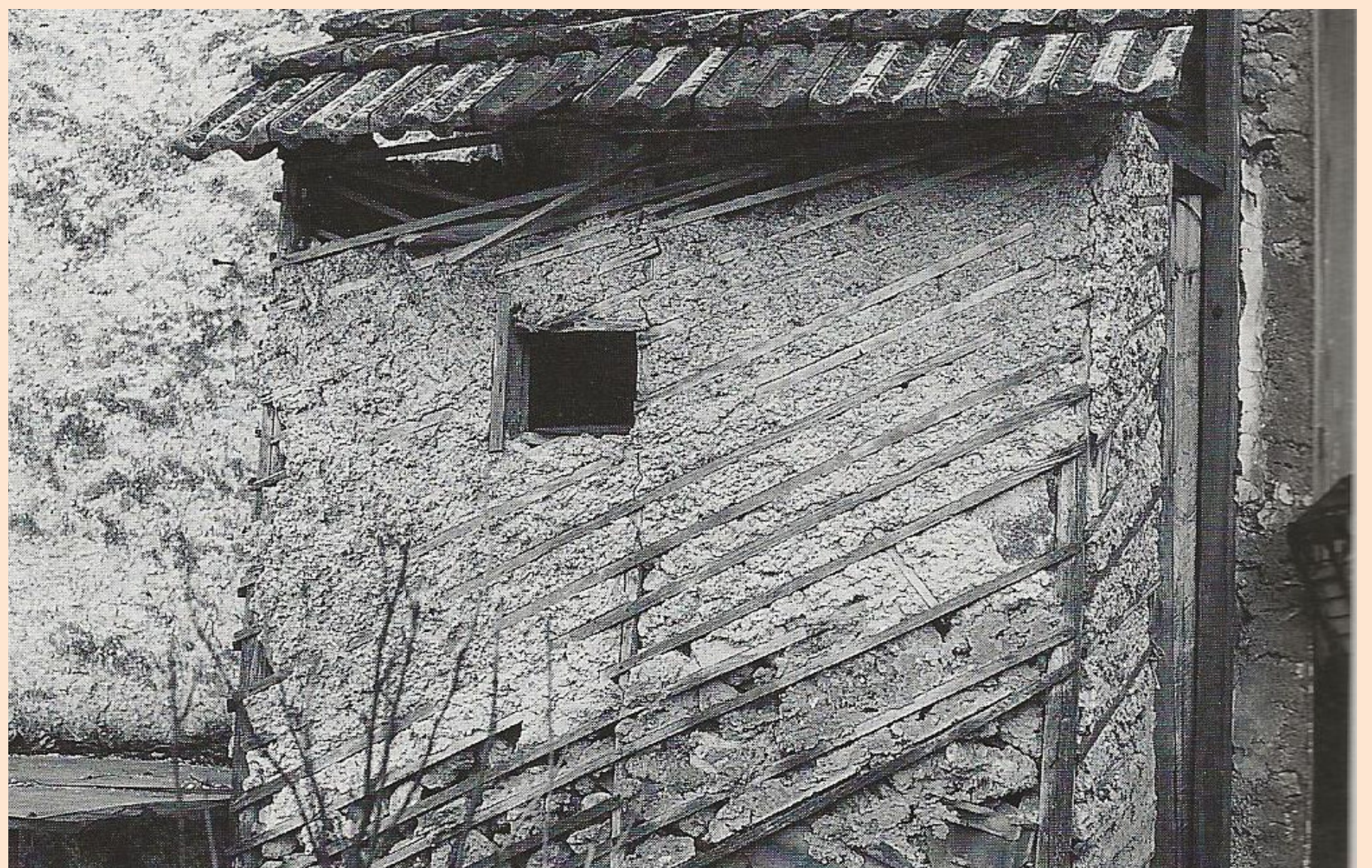
“Maso Bocari” (Monte Terlago). Si vedono i filetti in legno e i tovi, il vecchio sistema di costruzione delle pareti divisorie
