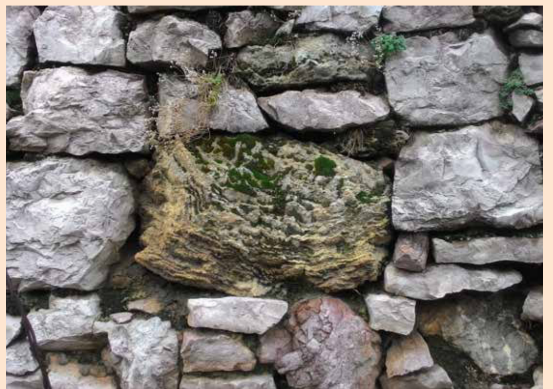
Esempio d’impiego dei mattoni di “tòf” tagliati da una segheria ad acqua
