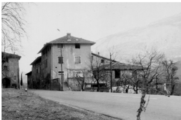
El cason gris ( a destra ) e di fronte l'edificio, chiamato " Brolam " e abbattuto, quest'ultimo nel 1970 per l'allargamento della statale gardesana
