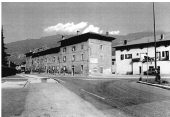
Una vecchia immagine del cason ros prima della ristrutturazione (1999)
