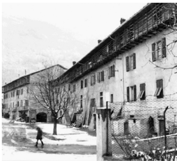
La facciata sud del cason nòf con il piazzale, rivolto verso la campagna
