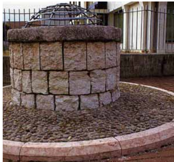
L'antico pozzo del Cason Nòf, recuperato con i lavori di sistemazione urbana dell'area
