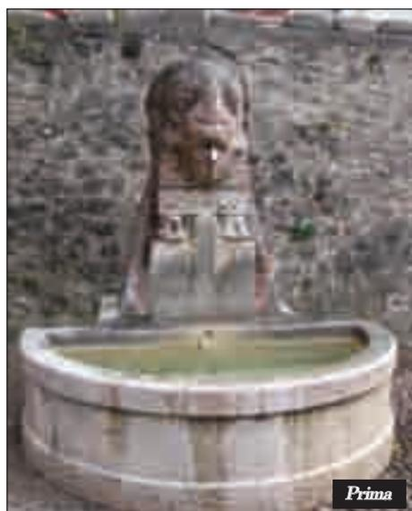
tra, e per eliminare i depositi di polveri e particolato che oscuravano la superficie. Le prime fasi di pulitura hanno messo in evidenza uno strato più o meno spesso di boiaccia di cemento che è stato steso sulla superficie del bordo vasca per accentuare l'inclinazione e favorire lo scorrimento dell'acqua all'interno del catino, probabilmente in seguito all'ultimo risa-
