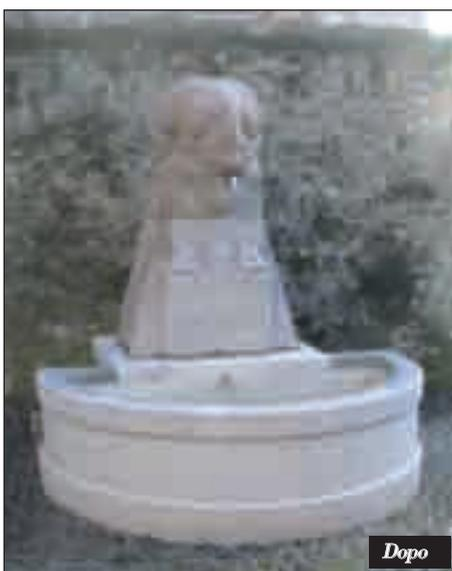
namento dell'interno vasca. In molte parti si trovavano anche depositi di calcare stratificato anche di notevole spessore dovuto allo stillicidio dell'acqua molto calcarea sulle parti perimetrali della vasca e sulla parte frontale dove è presente la scritta incisa.
