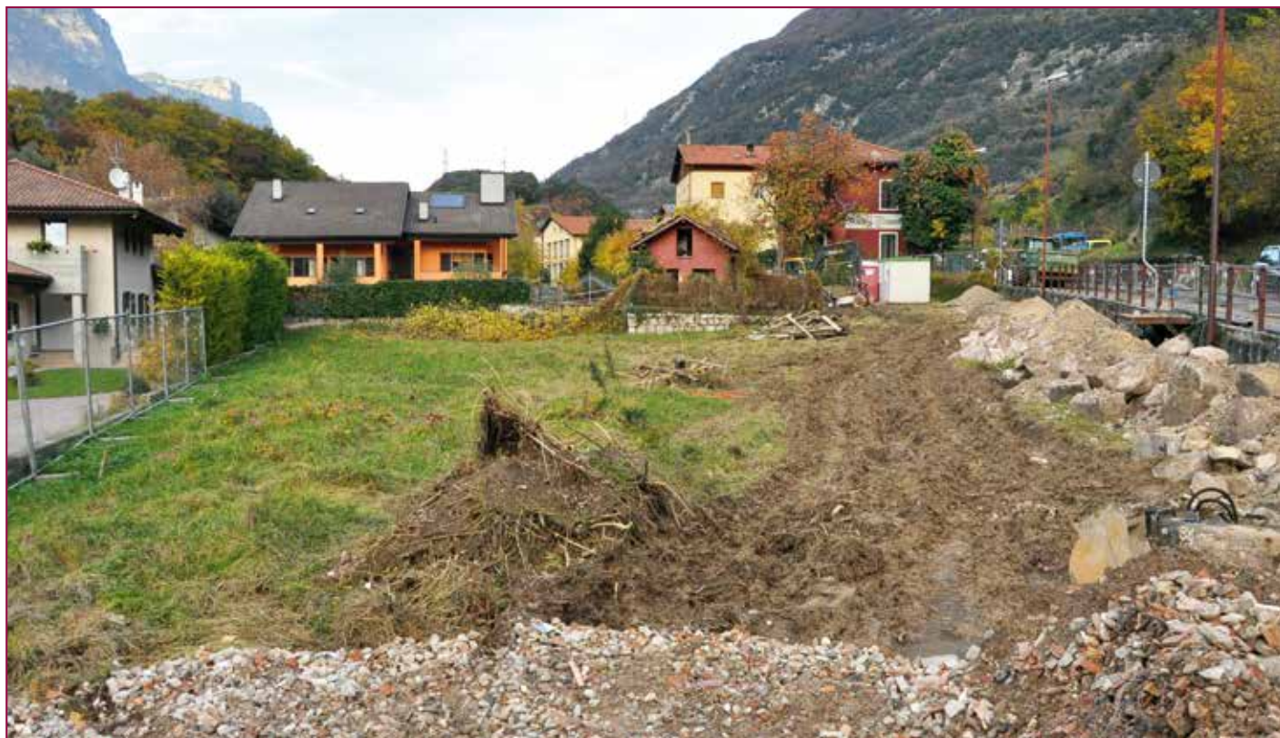
^ Inizio lavori case Itea
