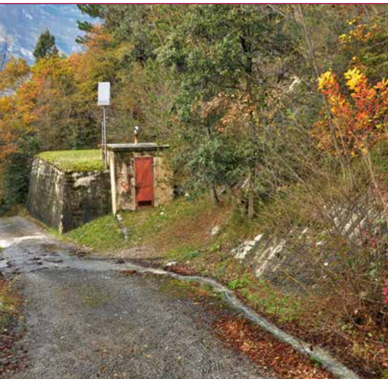
^ Nuovi lavori al serbatoio dell'acquedotto comunale
