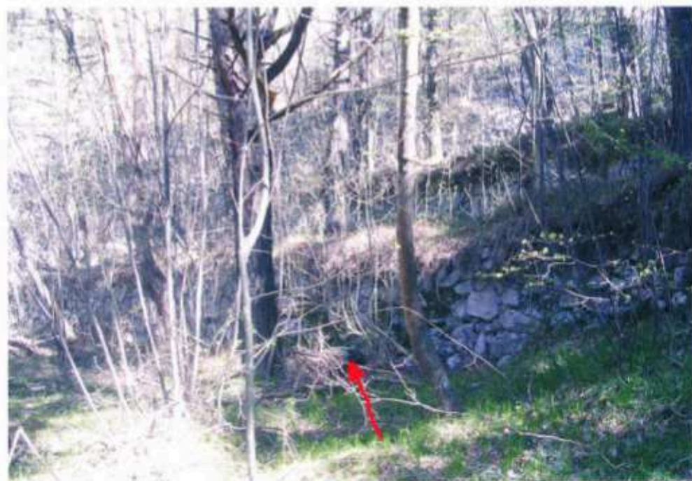
Terrazzamenti di Clei abbandonati. La freccia rossa indica un copertone di automobile abbandonato.
