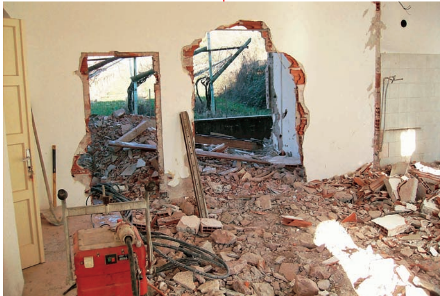
Fraveggio, lavori alla ex scuola
