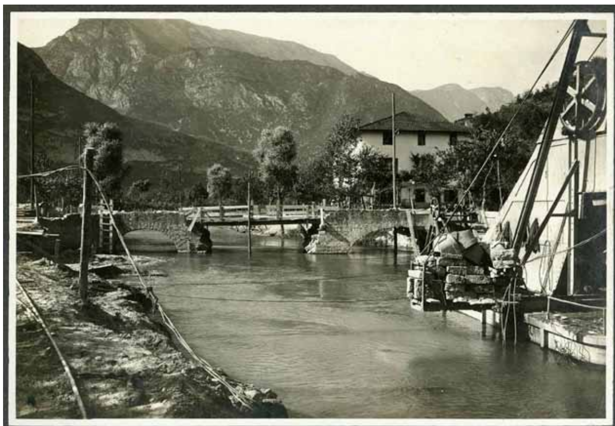
In fronte sono mostrate due diverse fasi dell'ampliamento del Rimone, in questa pagina è mostrata la demolizione a Ponte Oliveti del vecchio ponte (ricostruito nel 1886) per l'edificazione di uno in ferro.
